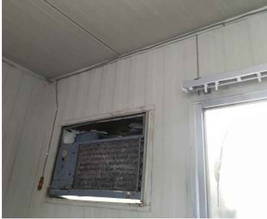
Figura 6-16 Instalación del cable
