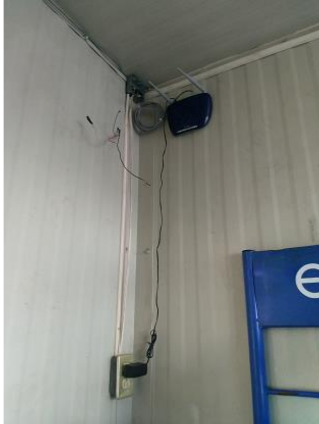
Figura 6-17 Instalación del Router
