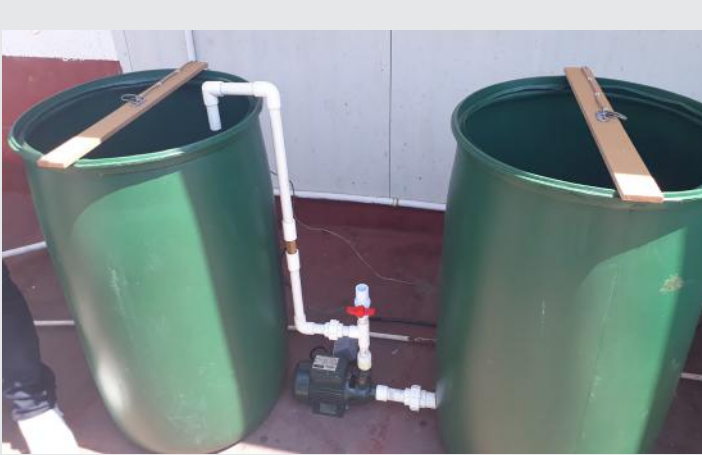
Figura 6. Descripción gráfica de los contenedores de agua y la bomba de rebombeo de agua
