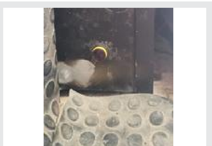
Figura 6. Evidencia del sensor instalado en la unidad de transporte.
