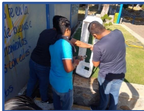
Estudiantes de servicio social llevando a cabo mantenimientos preventivos a los equipos de aire acondicionado del TecNM campus Acapulco.
